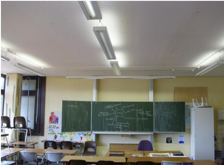
Neue Beleuchtungsanlage von Glamox mit dimmbaren elektronischen Vorschaltgeräten (EVG) DALI
