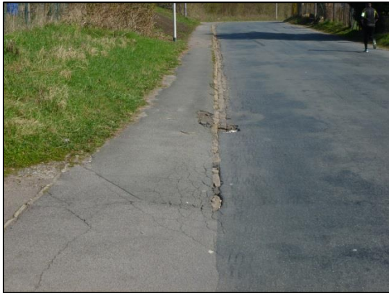
Abbildung 49: Straße Rohrser Warte II
