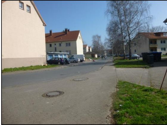
Abbildung 47: Straße Kuckuck II
