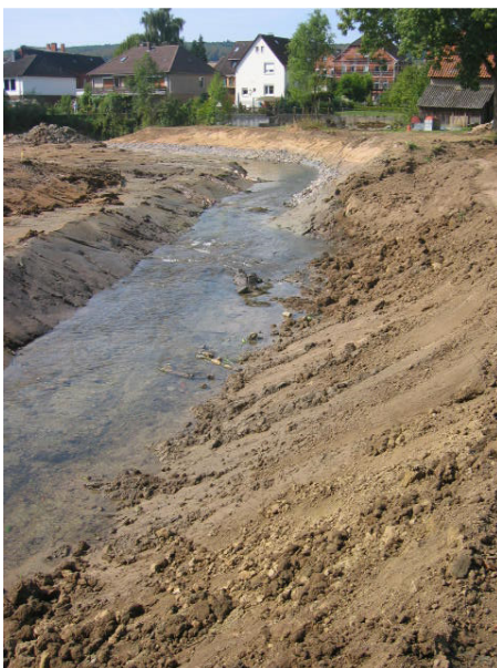
Der neue Hamellauf während der Bauphase im Sept. 2009 ...
