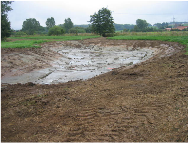
Die Flutrinne während der Bauphase im Sept. 2009 ...
