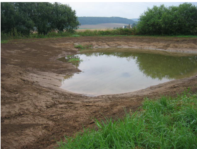
Die Flutmulde während der Bauphase im Sept. 2009 ...
