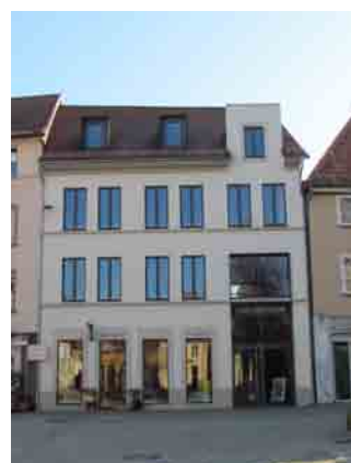
Abbildung 34: Haus der Kirche. Quelle: Eigenes Foto, 2014
