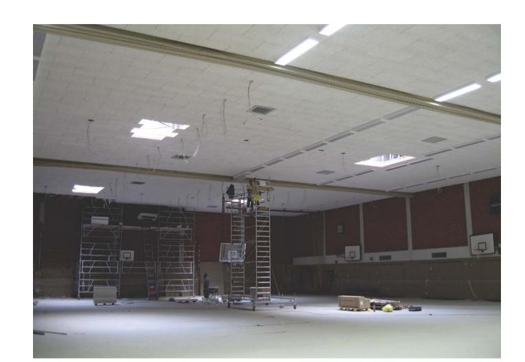
Das hat zur Folge, dass ein Wechsel der Beleuchtungskörper nur noch alle 15 Jahre notwendig ist. Zusätzlich ist das Beleuchtungssystem mit einer dynamische Lichtregelung, in 3 Beleuchtungsstufen, ausgestattet worden. So kann die Lichtregelung nach Tageslichteinfall, Nutzungsart oder Nutzungsgrad gesteuert werden. Dadurch wird zusätzlich der Stromverbrauch reduziert.
