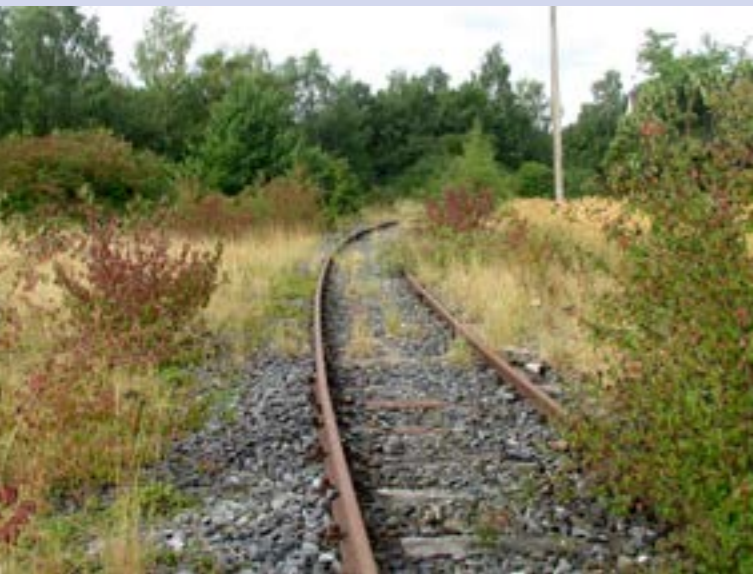
Abbildung 4: Alter Gleisanschluss Bailey Park. Foto: Stadt Hameln.
